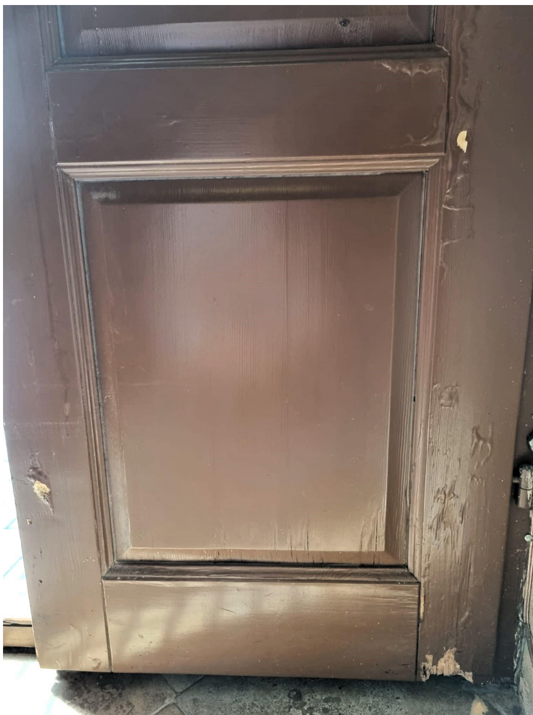
Fot. 5 Drzwi wejściowe do kaplicy
